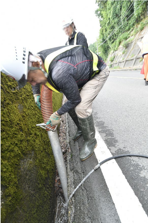
側溝内の堆積土砂を側溝清掃車で吸引している状況
