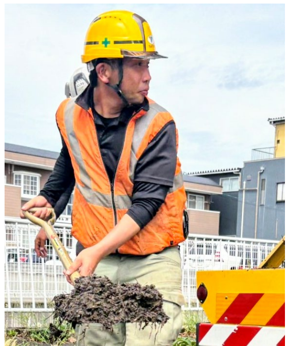
路面上の堆積土砂を人力で清掃している状況
