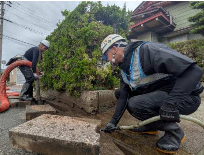
側溝内の堆積土砂に高圧噴射しながら側溝清掃車で吸引している状況
