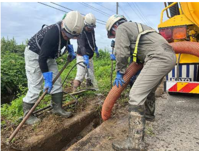
側溝内の堆積土砂に高圧噴射しながら側溝清掃車で吸引している状況
