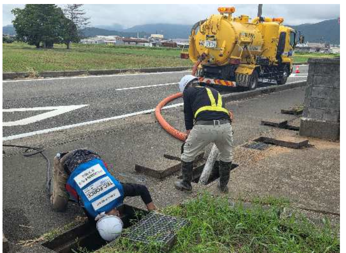
側溝内を直接確認しながら堆積土砂を側溝清掃車で吸引している状況
