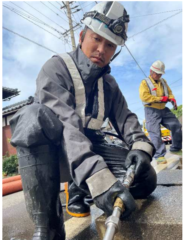
側溝内の堆積土砂に高圧噴射しながら清掃している状況
