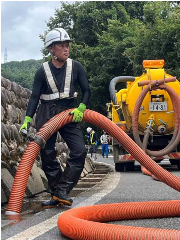
側溝内の堆積土砂を側溝清掃車で吸引している状況
