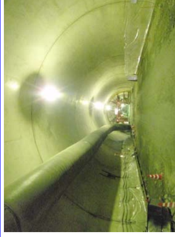
⑤トンネル坑内の覆工完了部
