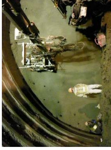
①発破作業状況(貫通の8m手前)
