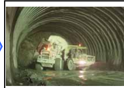
掘削・ずり積み込み状況
