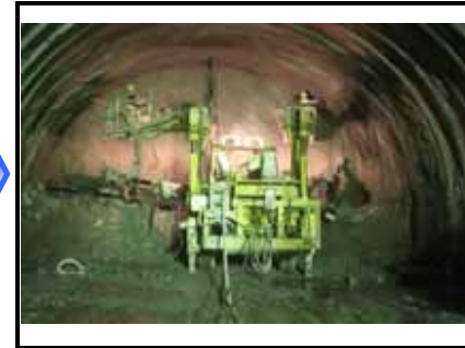
ロックボルト打設状況
