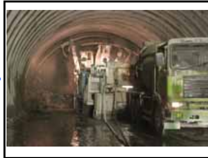
鋼製アーチ支保工建込み状況
