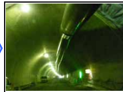
覆工コンクリート完了状況
