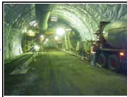
覆工コンクリート打設状況
