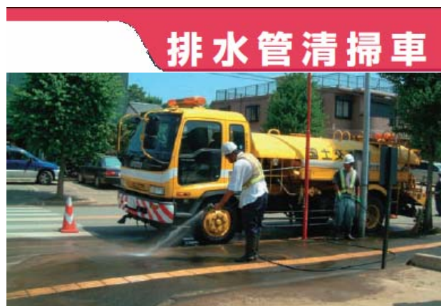
ノズルから噴射する高圧水で排水管に溜まった土砂を取り除きます
