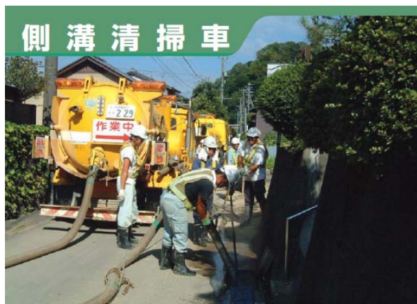
側溝に溜まった土砂を掃除機のように吸引し搬出します
