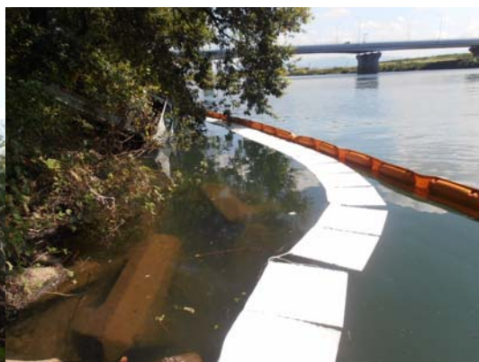
フェンス等 対策状況
