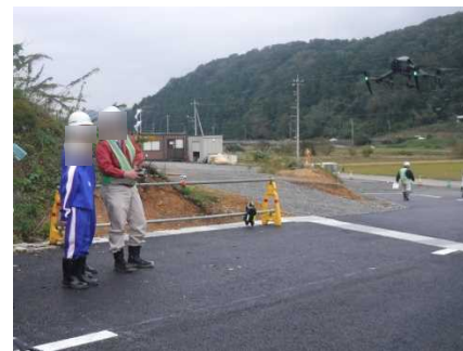
福井バイパスの現場で ドローンの撮影見学
