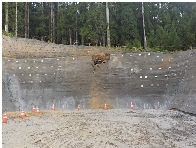
貫通後 (トンネル外)
