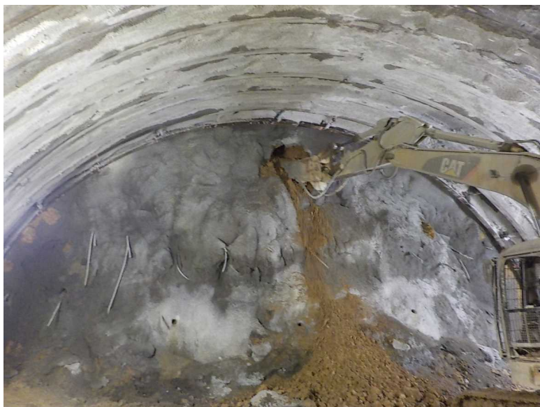
貫通前 (トンネル内)
