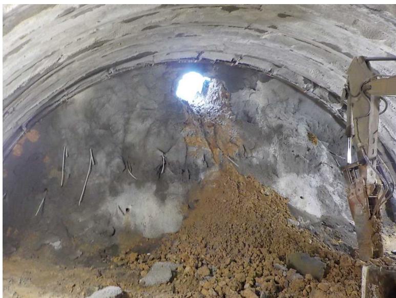
貫通後 (トンネル内)
