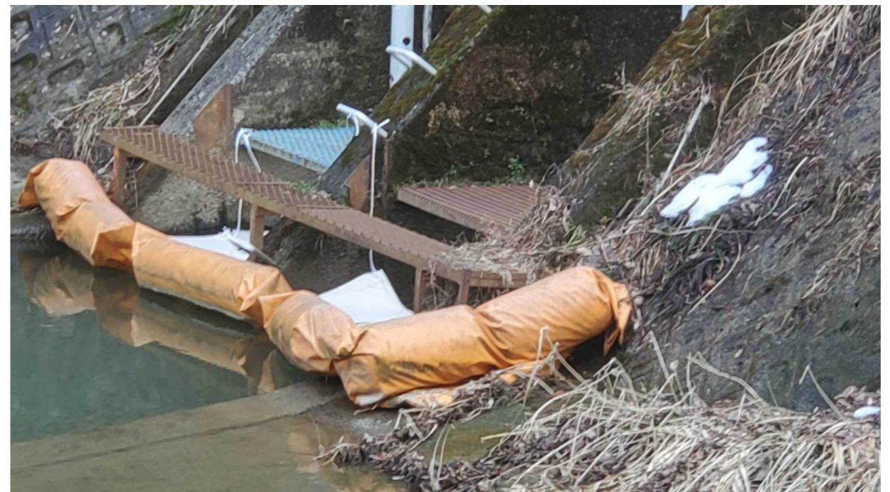
竹田川の対策状況 (水道管理事務所取水口)
