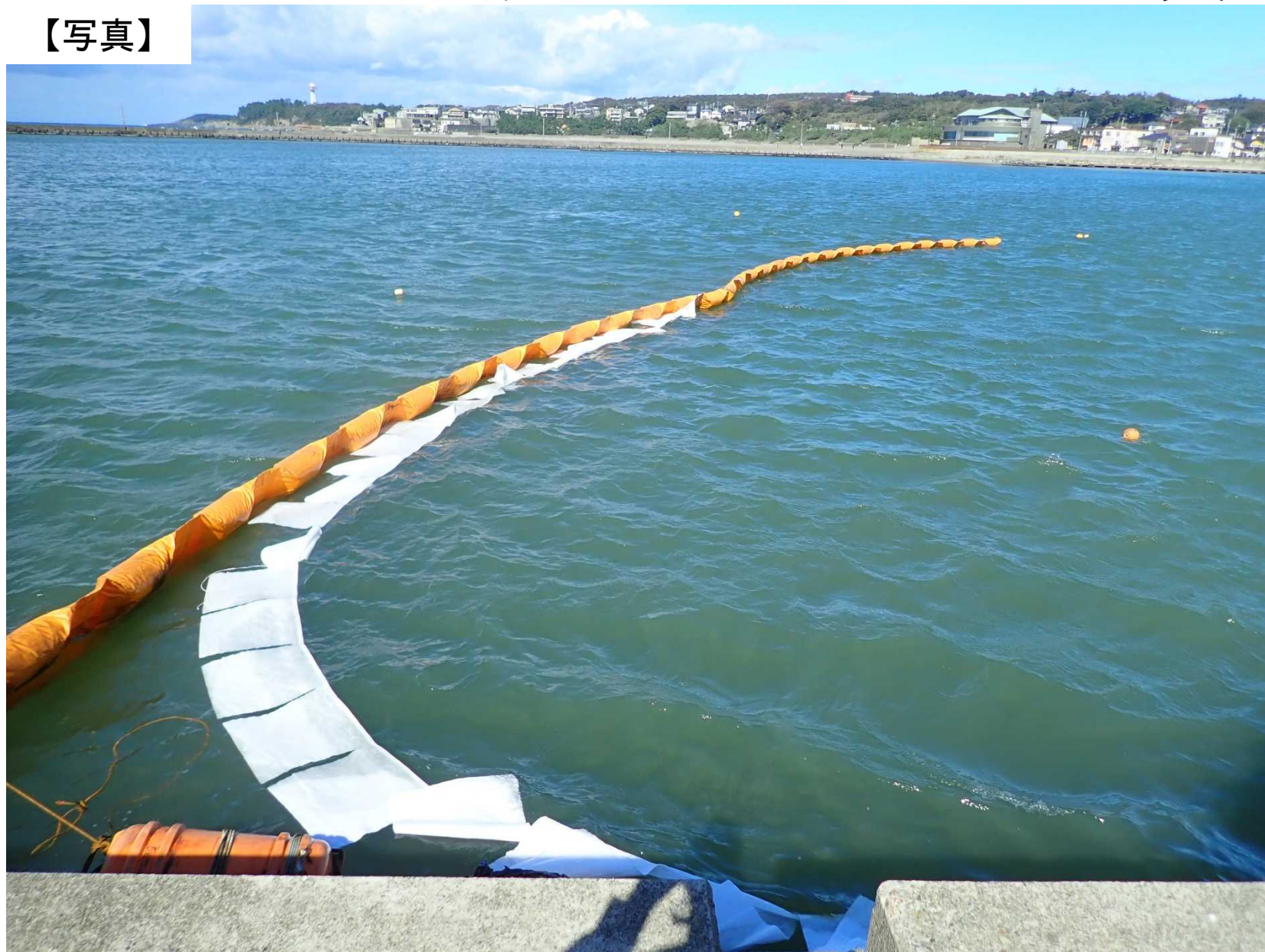
オイルフェンス及びオイルマット設置状況
