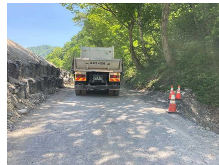
＜盛土材料を運ぶトラックの状況＞
