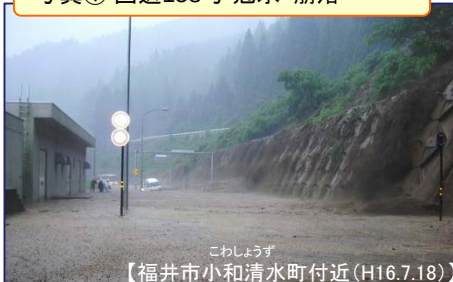
写真① 国道158号 冠水・崩落
