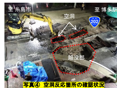
写真④ 空洞反応箇所の確認状況
