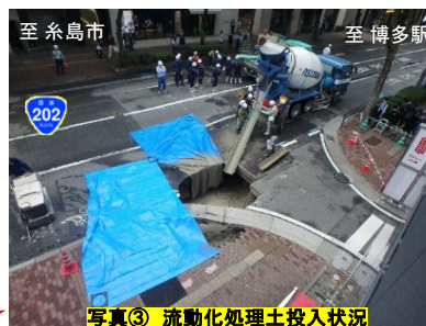
写真③ 流動化処理土投入状況
