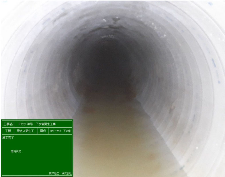
【管更生(φ800)施工後】
