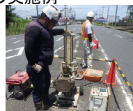
(貫入試験による調査)
