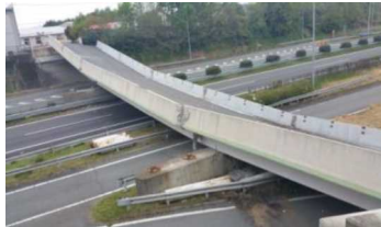
写真-1 県道小川嘉島線 府領第一橋
