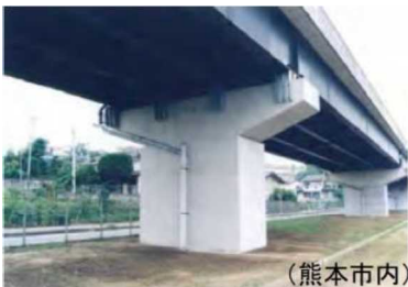
写真-3 国道3号 跨線部
