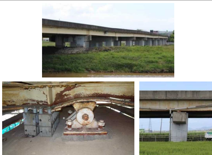
写真-1 支承部の損傷及び橋脚の傾斜 (九州自動車道・木山川橋)
