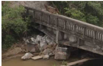
写真-2 平田・小柳線 田中橋
