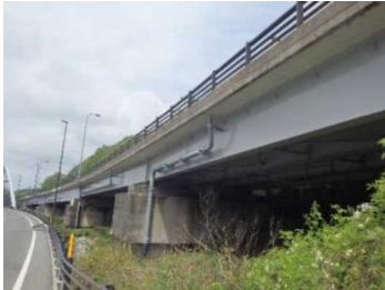
写真-4 阿蘇口大橋 (国道57号)
