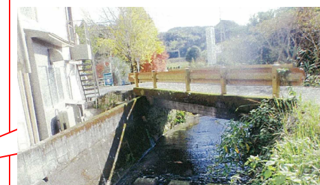
老朽橋の撤去
