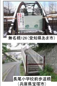
通行止め橋梁
