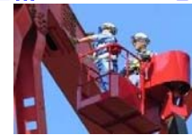
直轄診断(三島大橋)
