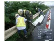
< 防護柵の取替 >
