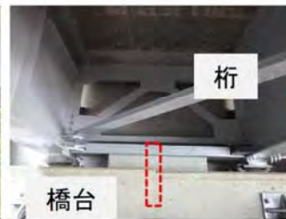
写真-5 アンカーバー のイメージ
