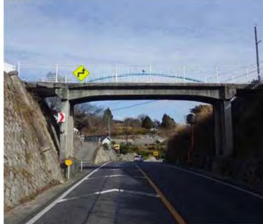
地方管理の跨道橋(未対策)
