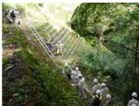
道路防災ドクターによる現地診断
