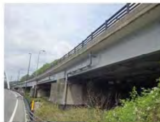
写真-4 阿蘇口大橋 (国道57号)
