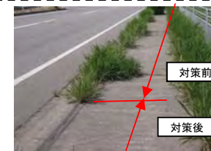
目地シーリング
