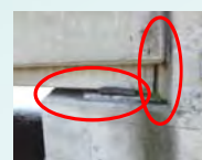
支保交換や桁端点検の空間なし
