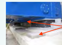
支保交換が容易な構造の例
