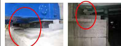
ジャッキアップに配慮した構造
