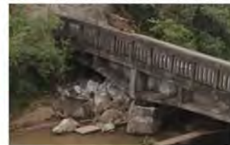
写真-2 平田・小柳線 田中橋
