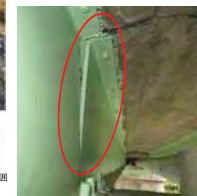
主桁の変形
