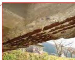
主桁の剥離、鉄筋露出
