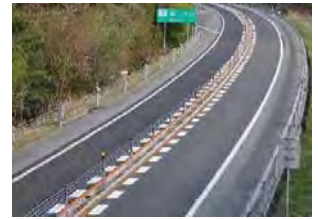
&lt;ワイヤーロープの設置事例&gt;
