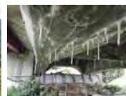
主桁のひびわれ
