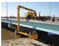
橋梁点検車による点検
