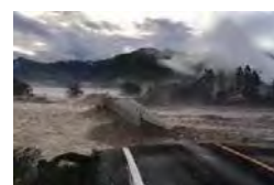
河川氾濫による落橋 (国道274号 北海道日高町千呂露橋)
