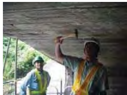
目視及びハンマーによる打音検査
