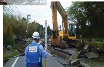
■重機による盛土復旧作業を実施
