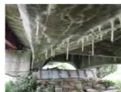
主桁のひびわれ
