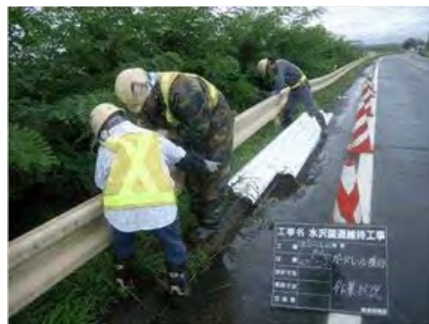
＜防護柵の取替＞
