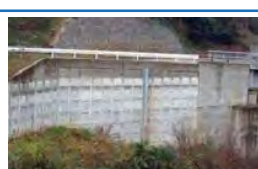
盛土 (補強土壁)
