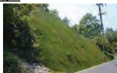
切土 (のり面保護)
