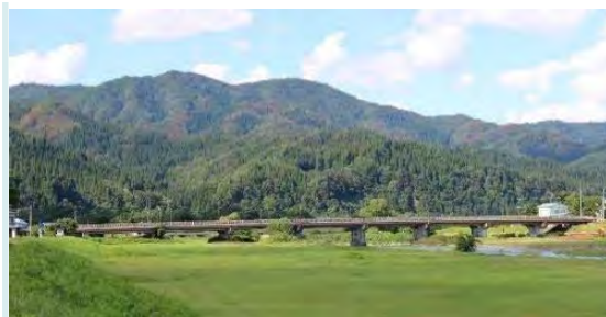
＜万石橋の状況＞
