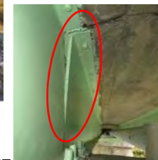
主桁の変形
