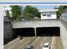
大型ボックスカルバート
