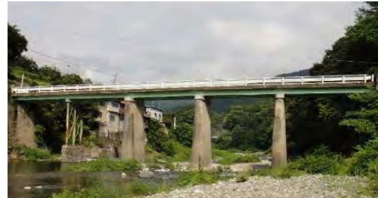
＜御鉾橋の状況＞
