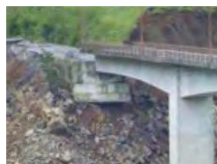
斜面変状による橋台の沈下
