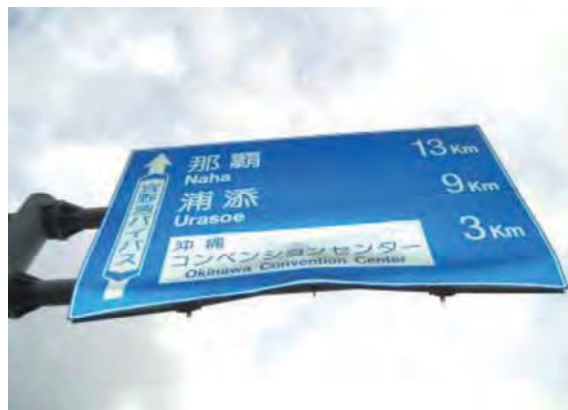
異常変形 (車両衝突)
