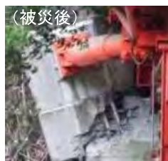
制震ダンパー取付部の損傷
