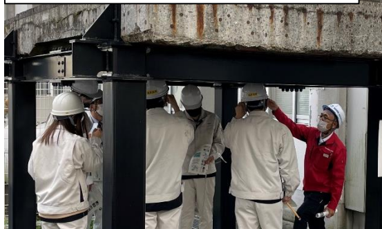
実習の様子（打音調査・ひび割れ調査）
