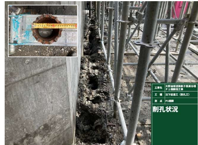
写真2 削孔した穴の状況
