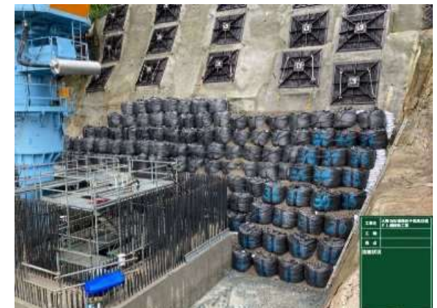
写真3 【対策後】大型土のうによる押さえ盛土
