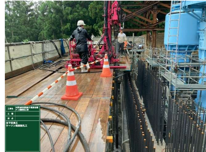
写真1 沈下不能対策工事（削孔）の状況
