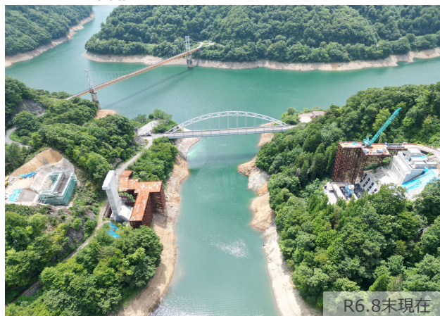
新子馬巢谷橋の状況
