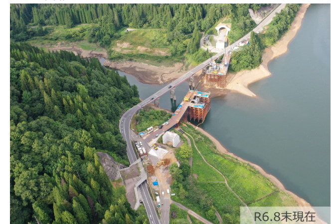
新林谷橋の状況
