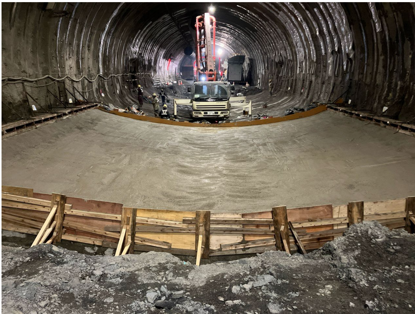
■ 写真 トンネル覆工（インバート）の施工状況
