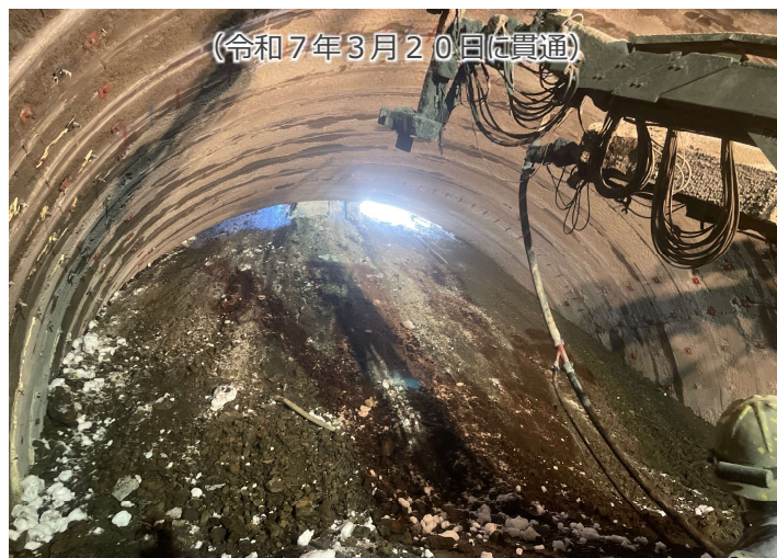
写真2 掘削状況（大谷トンネル）
