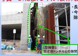
・長さ約9mのL型擁壁が完成しました。 ・今後はL型擁壁と旧疋田トンネルとの 隙間を埋め戻していきます。
