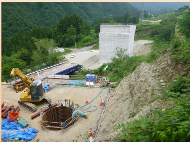
直径3m、深さ27mの深礎杭の掘削が完了し、鉄筋の組み立て作業を行っています。
