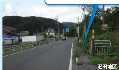
歩道の状況(未整備区間)
