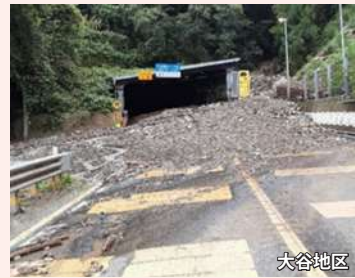
令和4年8月の豪雨災害時の土砂流出状況
