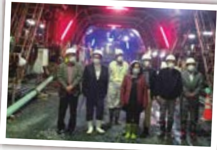
和泉トンネル坑内の見学
