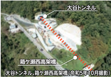
大谷トンネル、箱ヶ瀬西高架橋(令和5年10月撮影)
