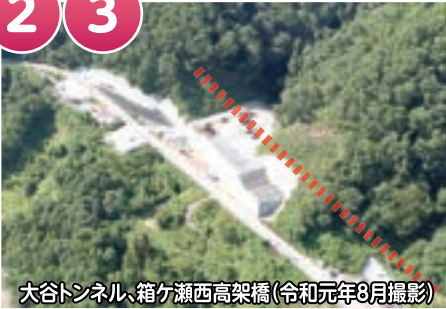
大谷トンネル、箱ヶ瀬西高架橋(令和元年8月撮影)
