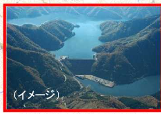
九頭竜川上流ダム再生(国)
