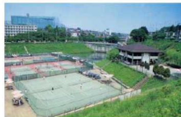
雨水貯留浸透施設の例(防災調整池)
