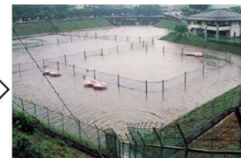
雨水貯留浸透施設の例(防災調整池)
