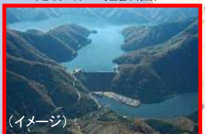
九頭竜川上流ダム再生（国）
