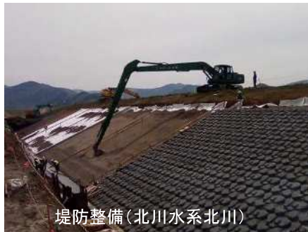
河道掘削(北川水系北川)
