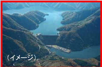
九頭竜川上流ダム再生(国)
