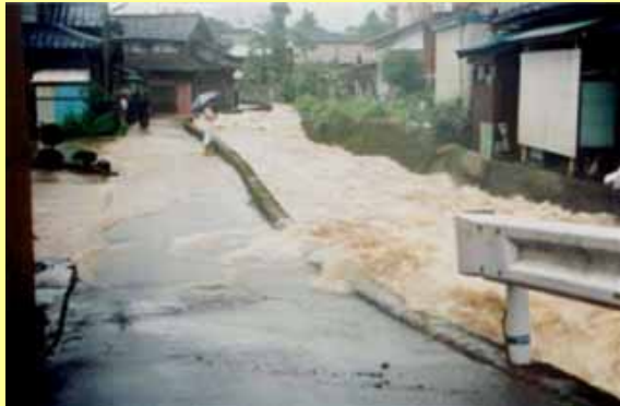
氾濫状況(義宣寺橋付近)
