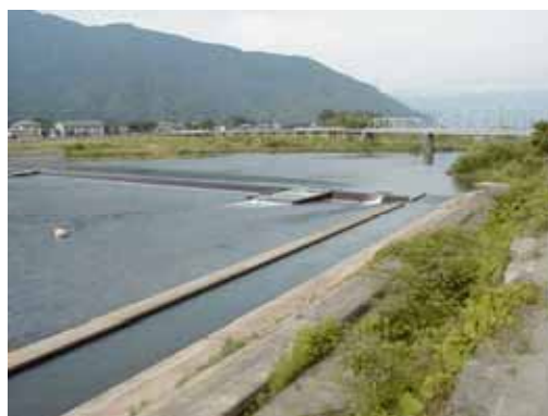
九頭竜川 小舟渡取水堰 (永平寺町藤巻付近)
