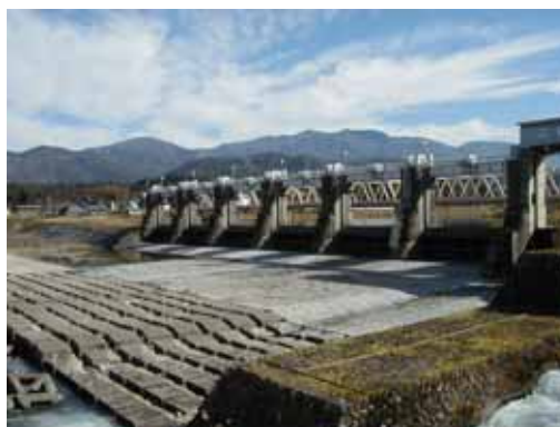
九頭竜川 下荒井堰 (勝山市遅羽町下荒井)
