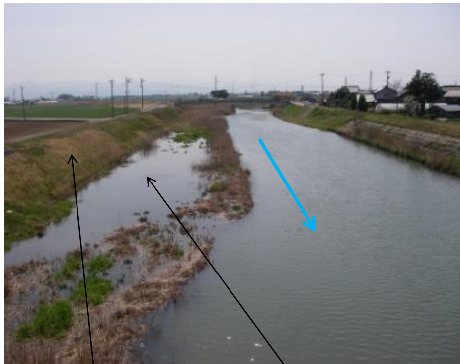
状況写真 ①
