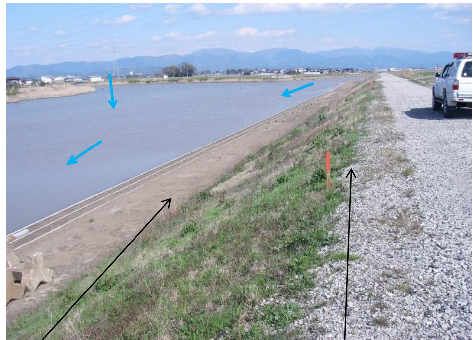
状況写真 ①
