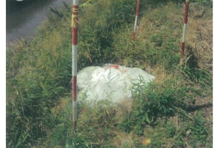
堤防陥没した3か所に土のう詰め（H26.5.30）
