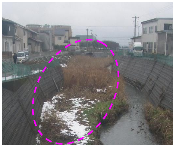
磯部川（坂井市）の浚渫状況
