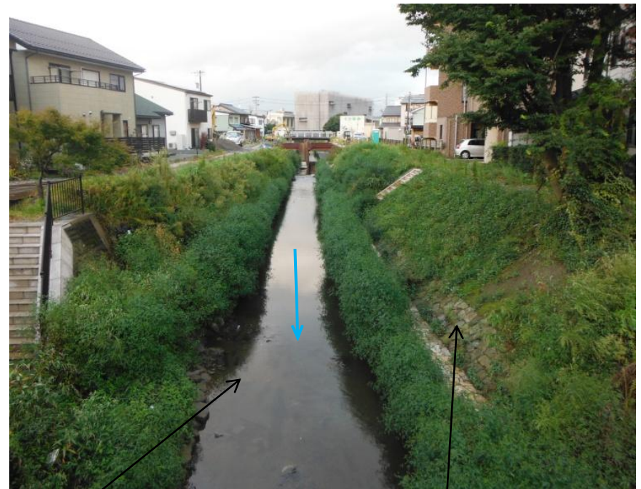
状況写真 ①
