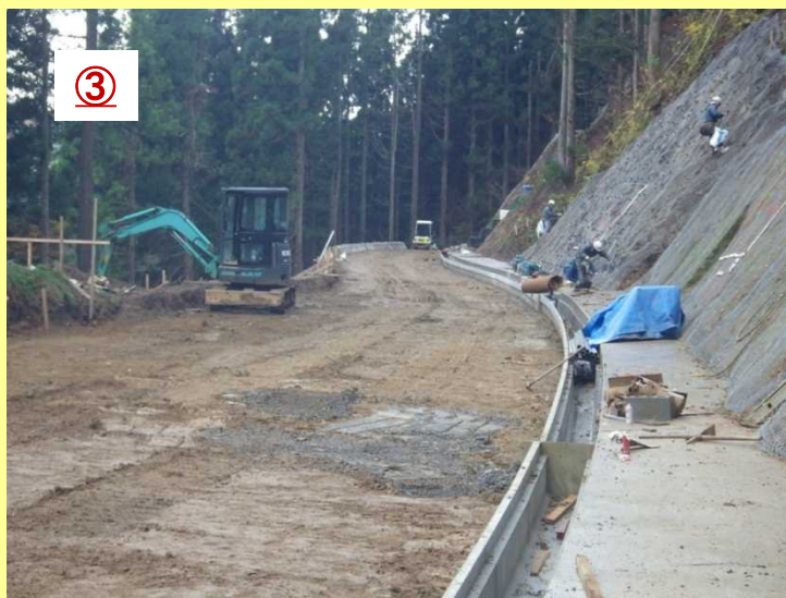
4号工事用道路 (H26.11)
