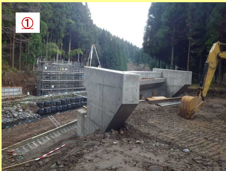
付替県道1号橋 (H26.11)
