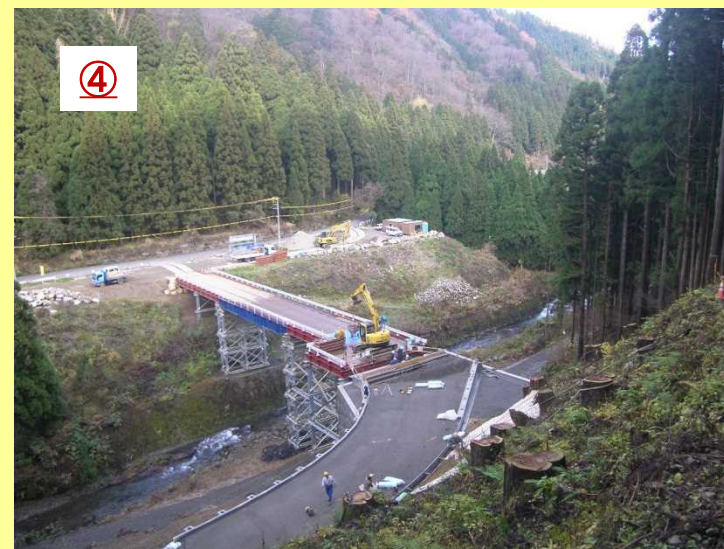
3号工事用道路 (H26.11)
