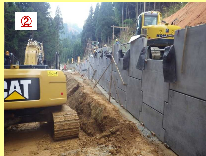
1号工事用道路 (H26.11)
