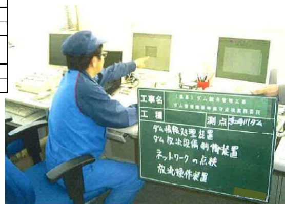
専門業者による点検状況
