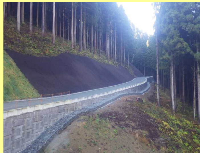
3号工事用道路 (H27.12)
