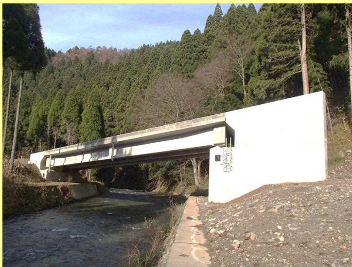
付替県道1号橋 (H27.12完成)
