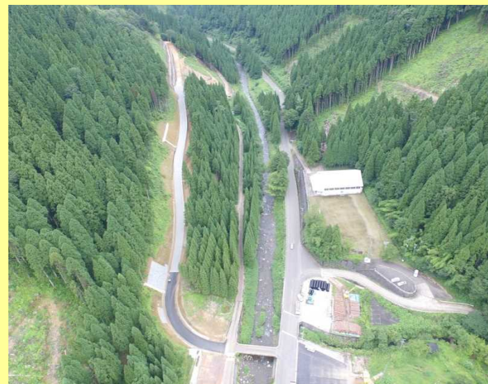
1号工事用道路進入部 (H27.9)
