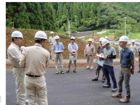
■現地視察会（1号工事用道路）
