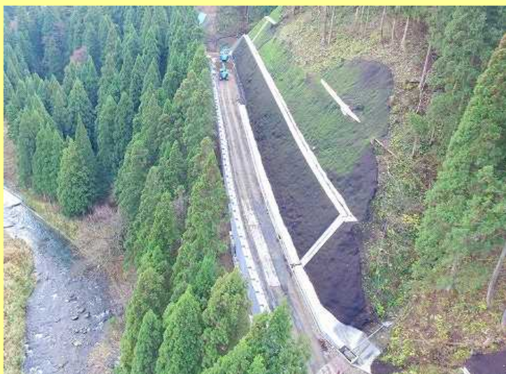
4号工事用道路 (H27.12)
