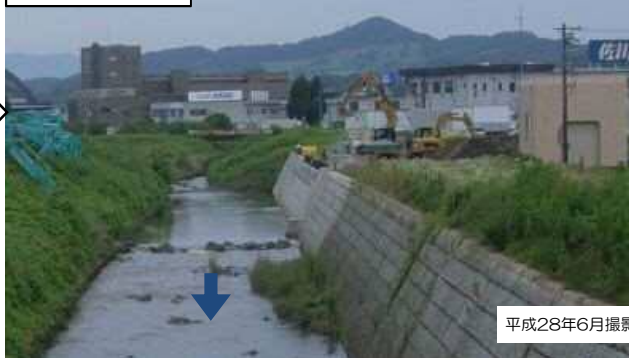
b 工事完成後
