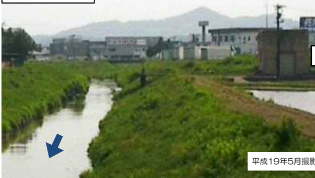
b 工事着手前
