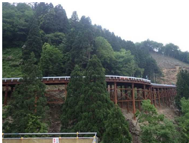
①1号工事用道路5工区工事
