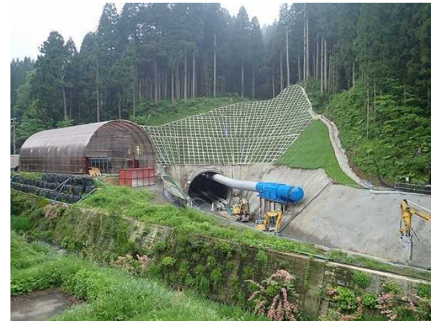
⑩水海川導水トンネル I 期工事
