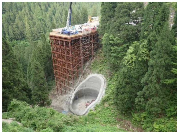
③付替県道7号橋工事
