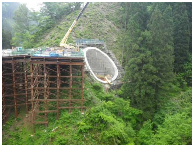
④付替県道8号橋工事
