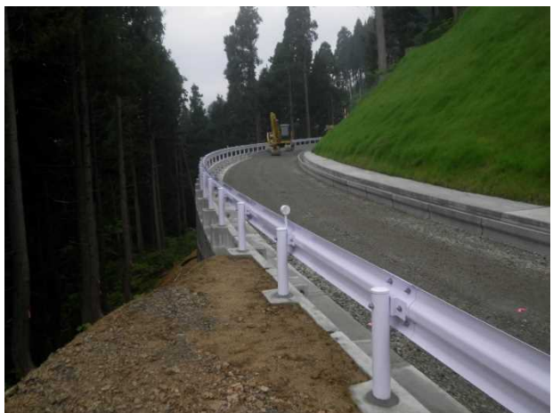
⑥4号工事用道路下小畑4工区工事
