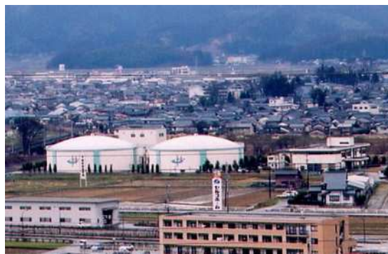
鯖江市上水道管理センター (鯖江市上鯖江町)
