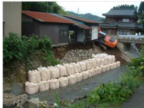
越知川 応急復旧（越前町上糸生）
