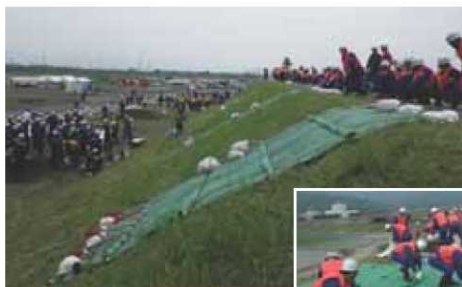
シート張り工
