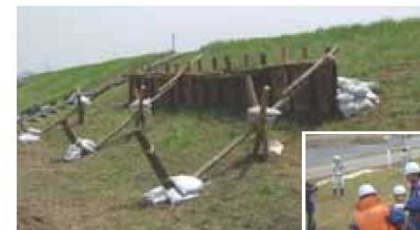
杭打ち積土のう工
