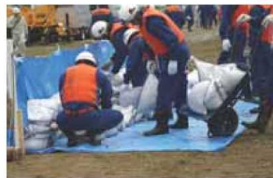
改良積土のう工
