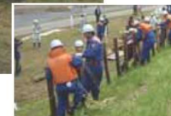
杭打ち積土のう工
