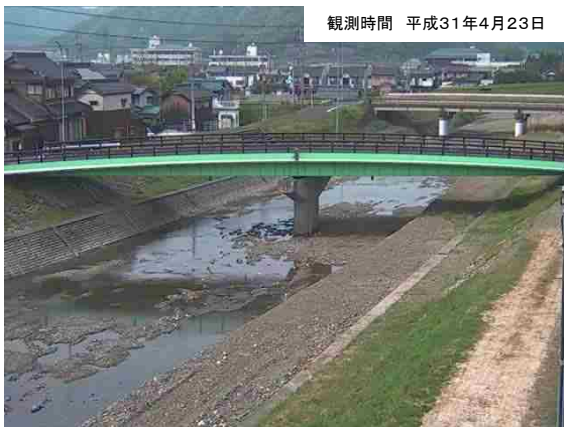
河川監視カメラ画像（遠敷川 小浜市（遠敷））
