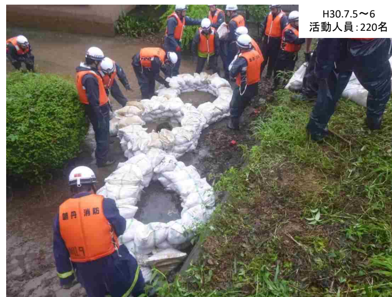
釜段工法による水防活動(越前町)
