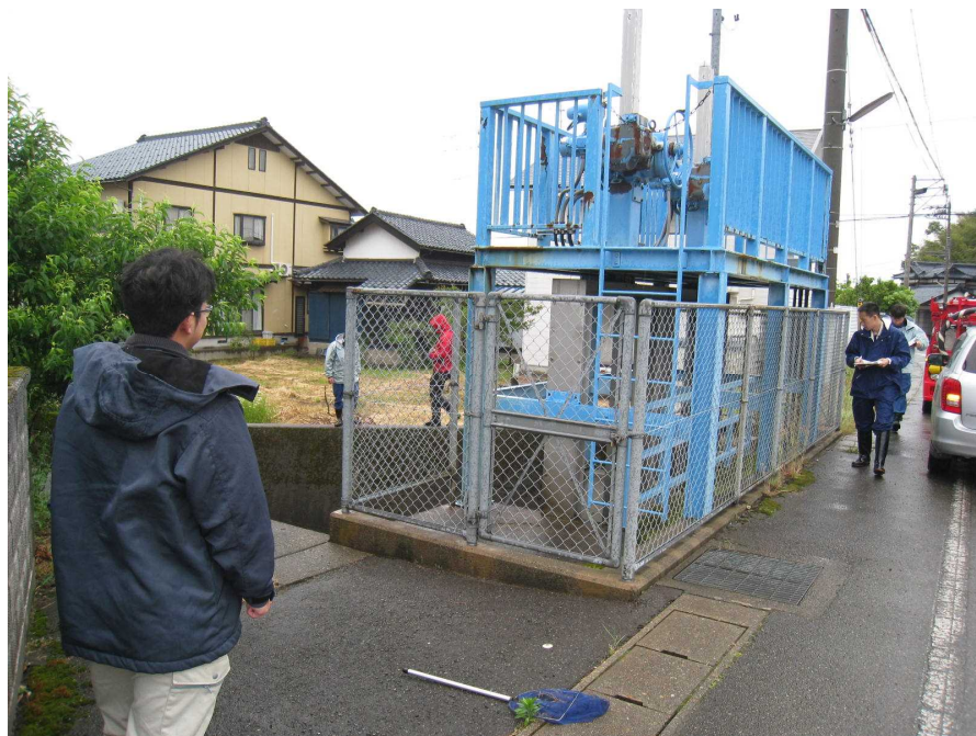
水防施設・河川パトロール
