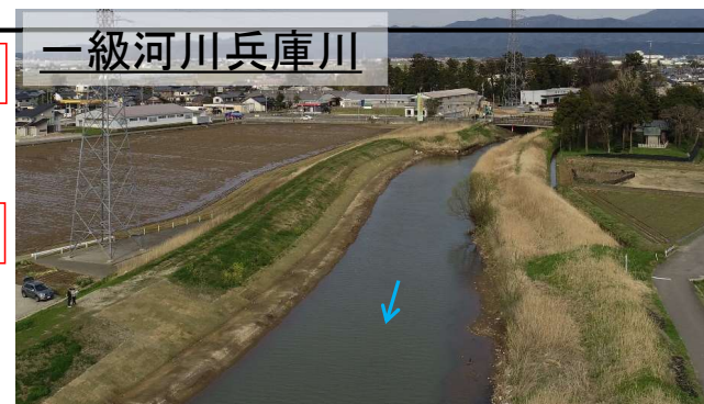
施工状況 (R2年4月撮影)
